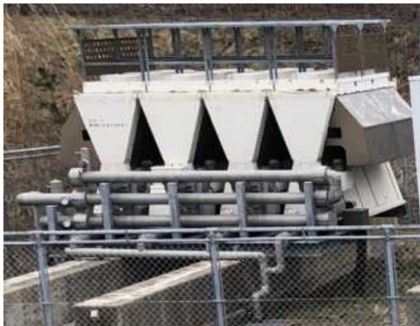
ヒートポンプチャラー
