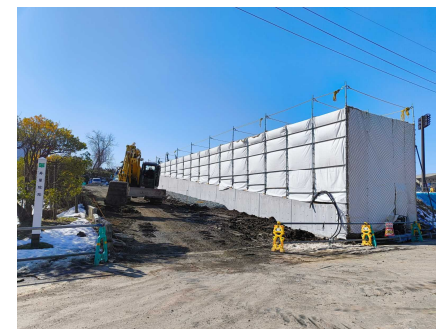
第2駐車場仮整備(スロープ等整備)
